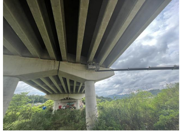
고소점검차를 이용한 근접조사
