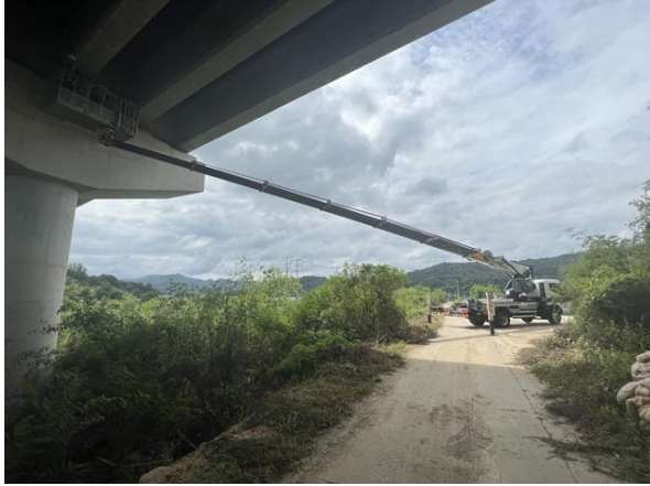
고소점검차를 이용한 근접조사
