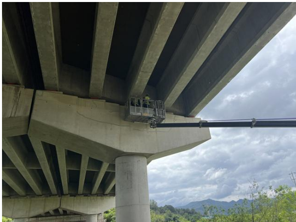
고소점검차를 이용한 근접조사
